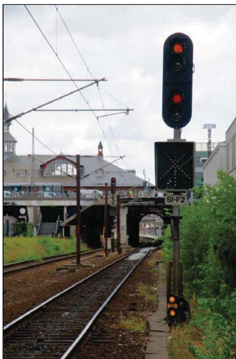
SI-signal F2 på Østerport. Kun hvis rangeringen er aftalt, må signalet passeres, når »dværghen« viser »Forbikørsel tilladt«.
