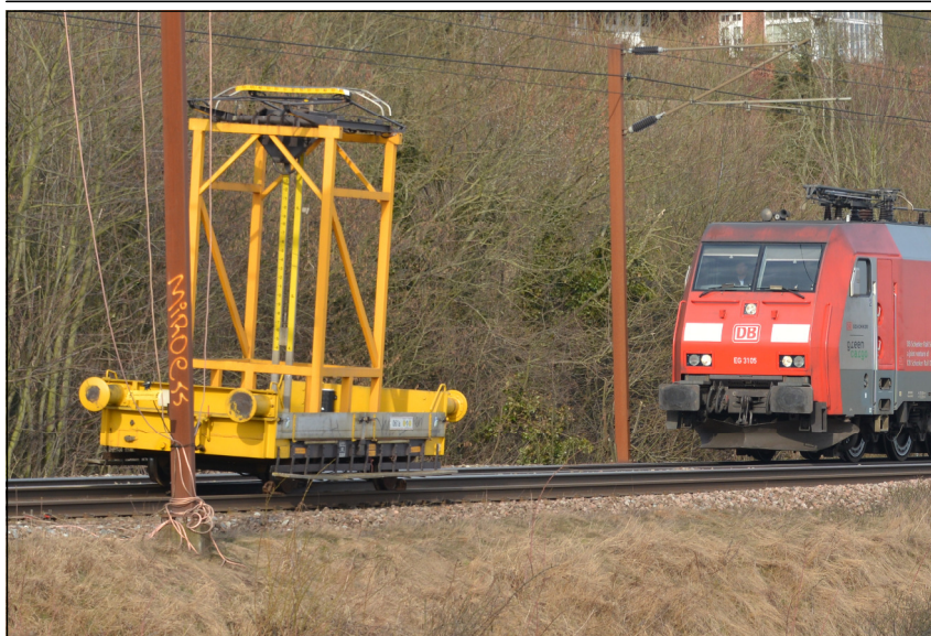
Et nøjere kig på billedet afslører, at der - korrekt - er udlagt hæmsko ved den lille køreledningstroljes hjul
